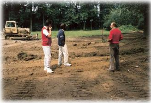
1986 Beginn der Bauarbeiten der ersten vier Tennisplätze
