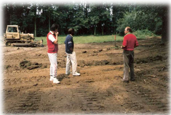
1986 Beginn der Bauarbeiten der ersten vier Tennisplätze
